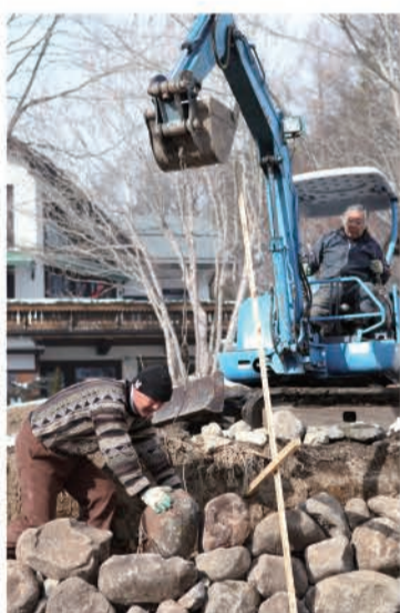
積む。石は重い。無理をすると腰を痛める。明日にさしつかえる。よって重機で吊る。
