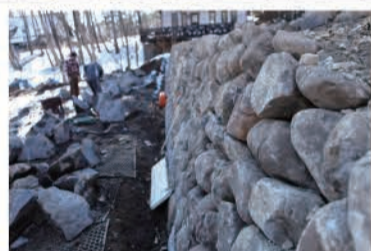
大小さまざまな石を組み合わせる。精巧なパズルのようだ。
